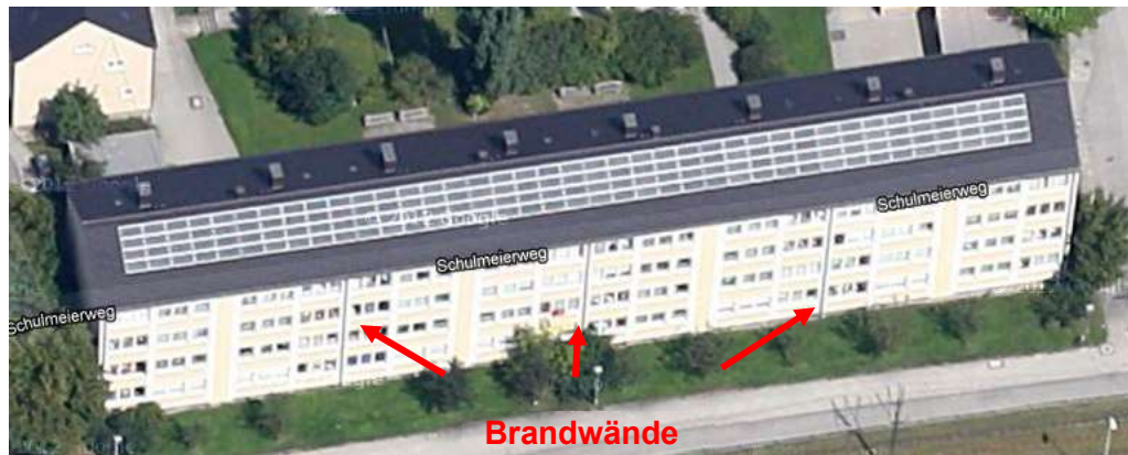
Abbildung 4: Negativbeispiel überbrückter Brandwände durch PV-Anlagen (Foto: Google Maps)
