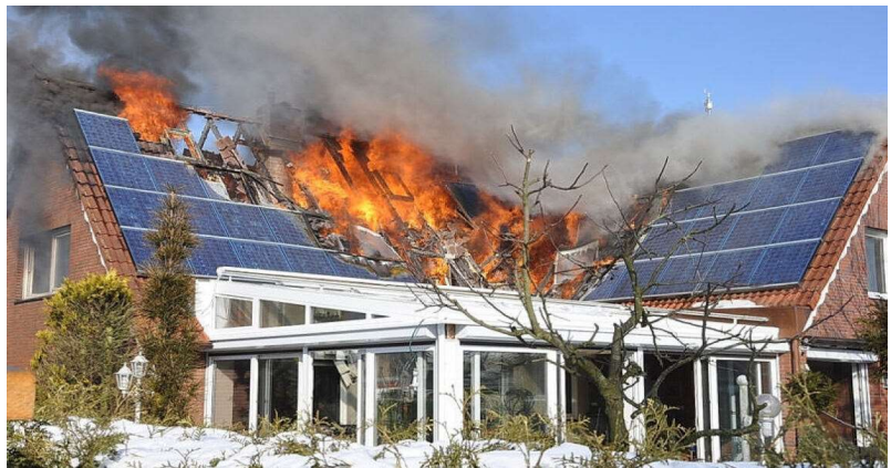
Abbildung 1: Brand eines Hauses mit Photovoltaik-Anlage (Bild: B. Wolters/Leer)
